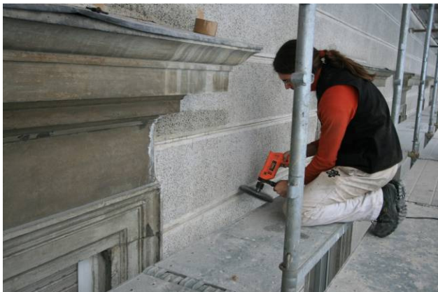
Operatori durante la rimozione delle croste nere, a secco e tramite risciacquo
