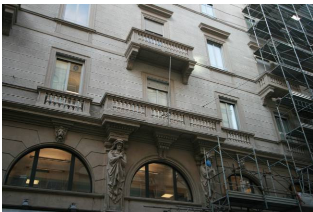
Porzione di facciata con cariatidi restaurate
