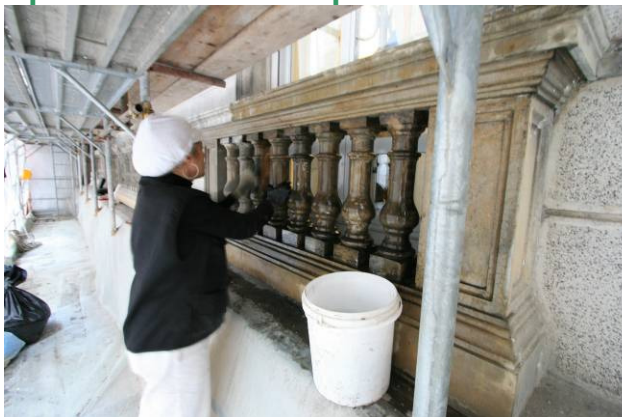
Operatori durante la rimozione delle croste nere, a secco e tramite risciacquo
